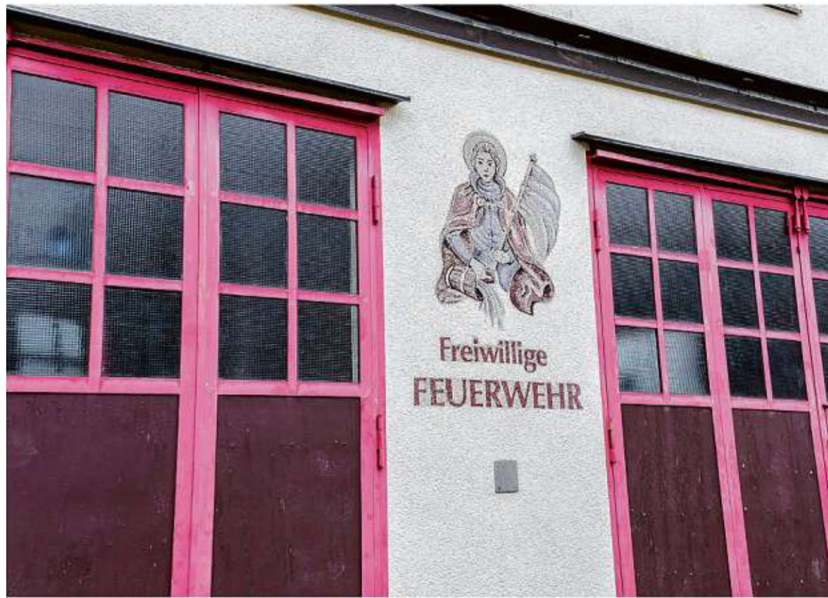
Gammelshausen hat sich trotz der prekären Haushaltslage einiges vorgenommen. Für die Erweiterung des Feuerwehrmagazins wurde ein Schlüssel-Grundstück erworben. Foto: Staufenpress
